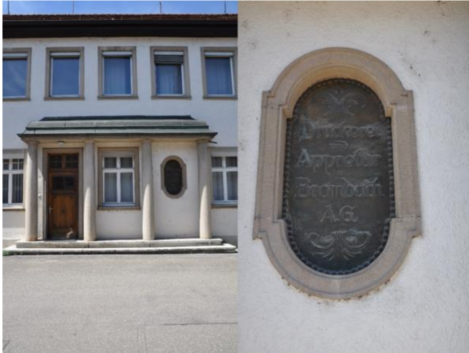
Verwaltungsgebäude, Juni 2019, Foto: Landesamt für Denkmalpflege
