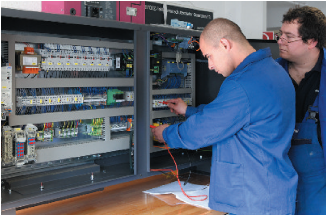
Die Kursteilnehmer überprüfen die Verdrahtung eines Maschinenschalt-schranks.
