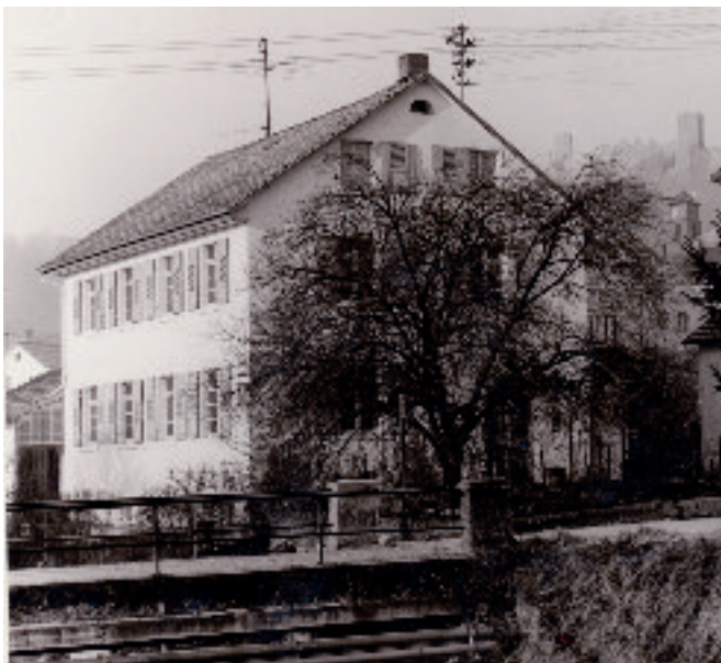
Seinen ersten Betrieb richtet Julius Kaltenbach im Erdgeschoss dieses Hauses in Haagen ein. Die Brücke über den Kanal gibt es noch heute, aber das Grundstück ist neu überbaut.
